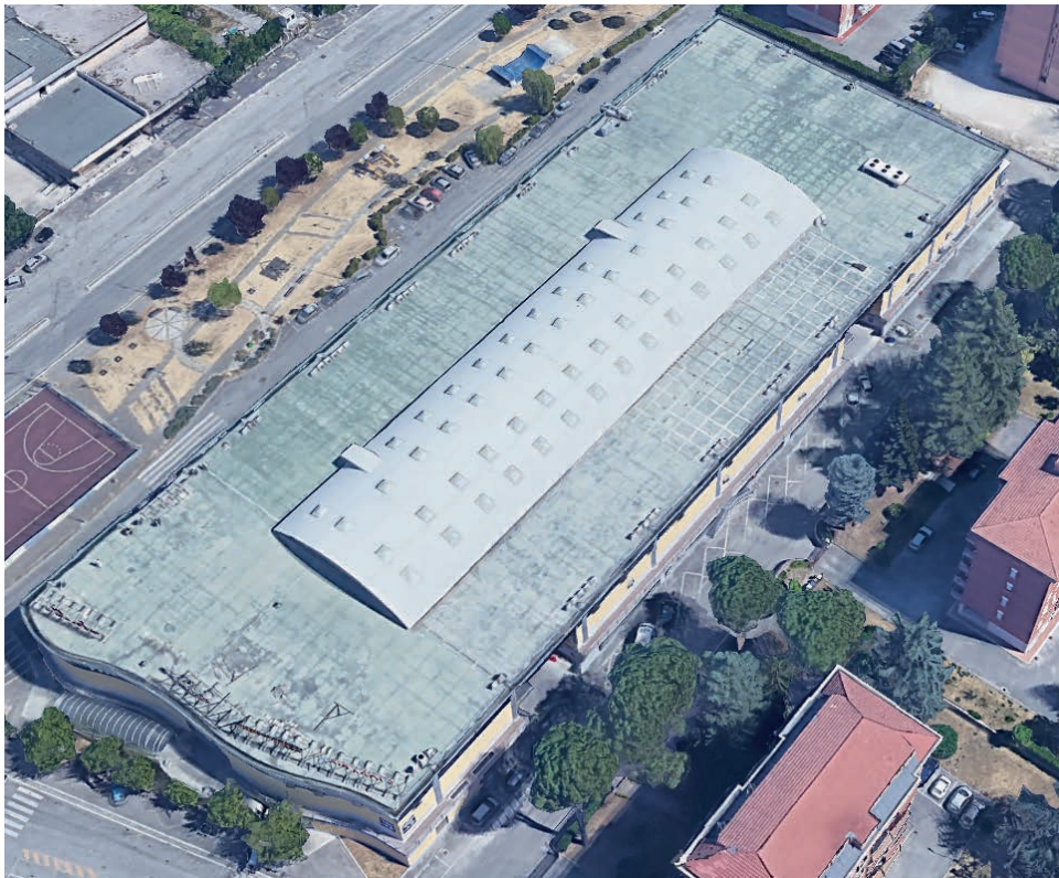
VISTA AEREA DELLA COPERTURA
